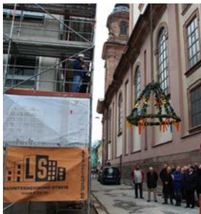
Der Richtkranz wird hochgezogen.
