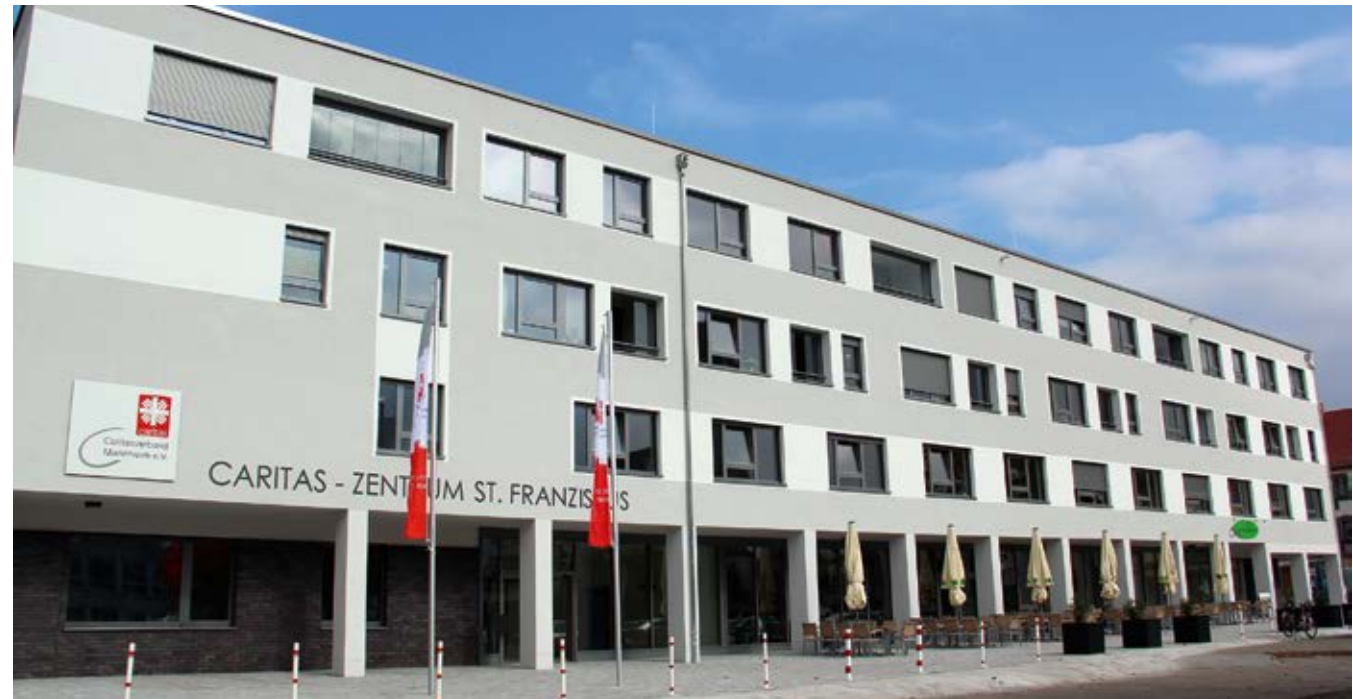
Großprojekt am Taunusplatz: Von 2013 bis 2015 wurde dort das neue Caritas-Zentrum St. Franziskus errichtet.
